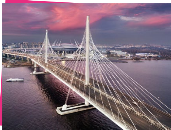
▲ Puente Betancourt: Ganador del VII Concurso Profesional Internacional de la Asociación Nacional de Agrimensores y Diseñadores en la nominación "Mejor Proyecto de Infraestructura de Ingeniería y Transporte"
