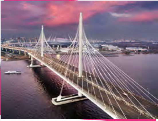
جسر بينانكورت هو الفائز في المسابقة المهنية الدولية السابعة للجمعية الوطنية للمصممين والمصممين في ترشيح « أفضل مشروع للهندسة والبنية التحتية للنقل».
